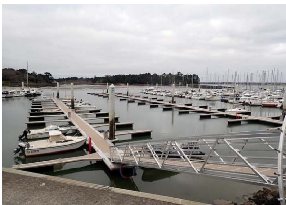
Les nouveaux pontons E et F remis en place
