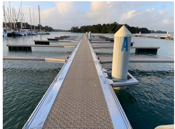
Le nouveau ponton visiteurs
