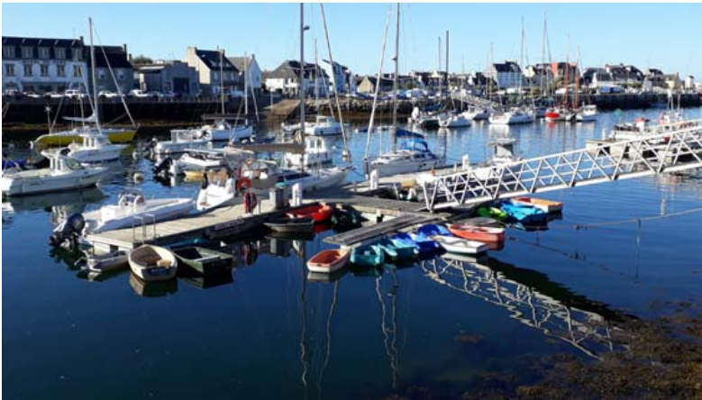
Les pontons visiteurs
