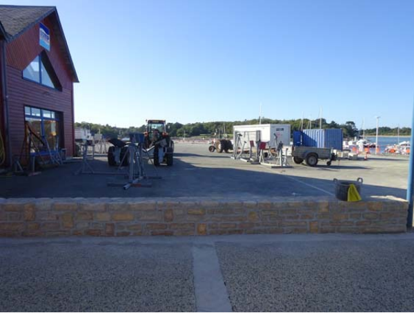
Les travaux se terminent sur la cale de carénage
