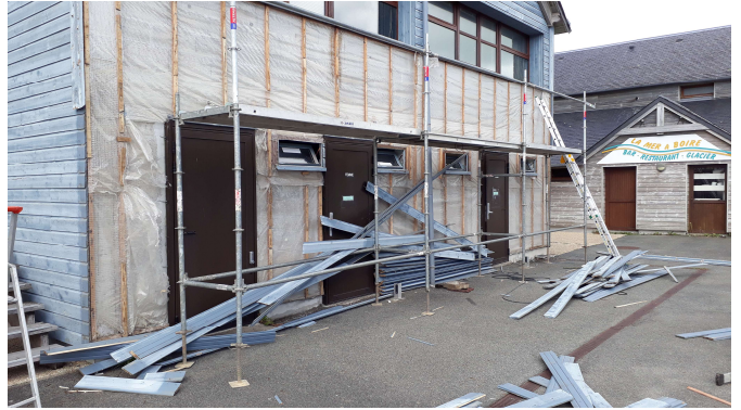
Sanitaires début des travaux
